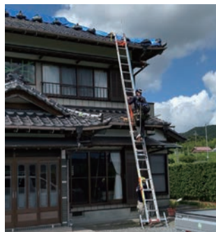
図7 二階建て家屋の施工風景
