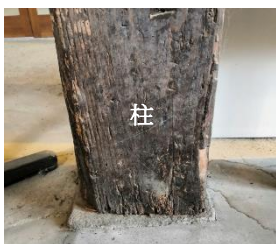
写真 1 柱脚接合部
