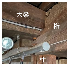
写真 2 柱梁接合部
