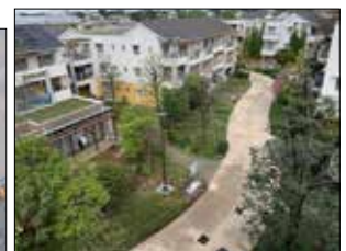
画像2 深沢環境共生住宅 6
